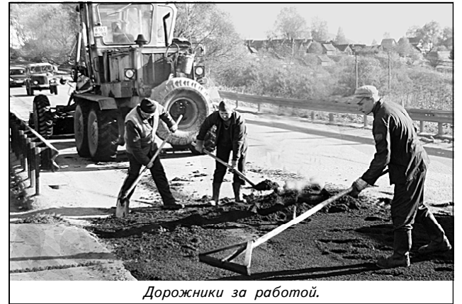
Дорожники за работой.
